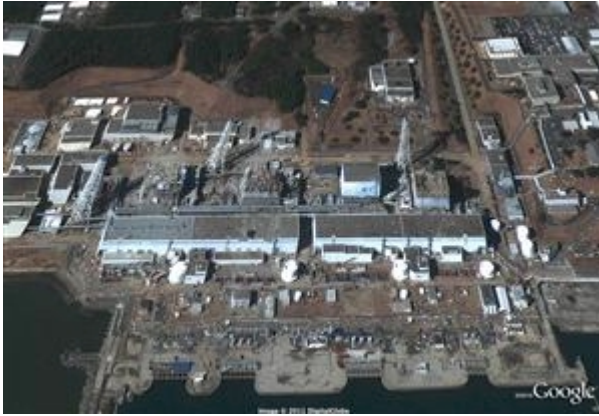
18日に撮影された福島第1原発の衛星写真。右から1号機、2号機、3号機、4号機(Google 提供・ロイター)
